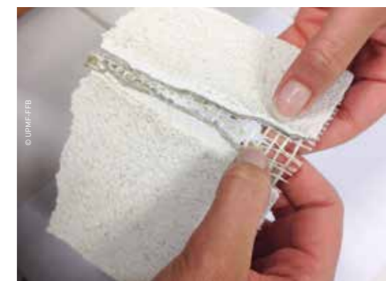
▲ SYSTÈME ITE NON CONFORME AVEC UNE ARMATURE DE L'ENDUIT EN ACRYLIQUE.
