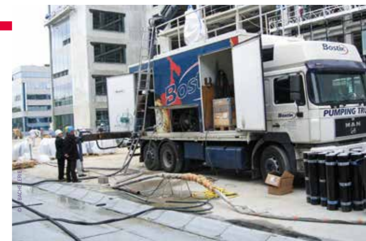
▲ LE CAMION POMPE QUI PRÉPARE ET ENVOIE L'ENDUIT DE RAGRÉAGE VERS LA SURFACE À TRAITER
