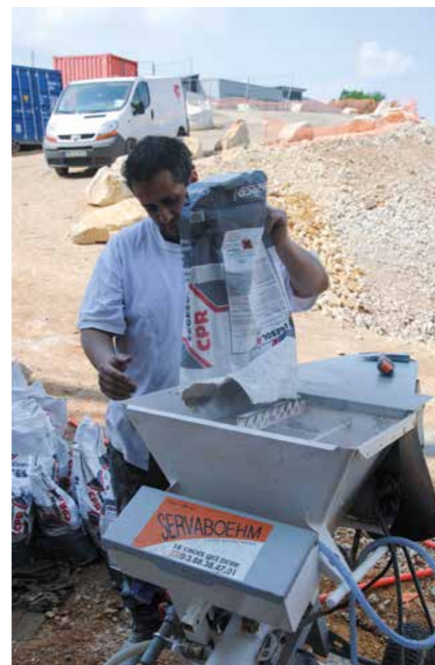
▲ L'APPROVISIONNEMENT S'EFFECTUE À DISTANCE GRÂCE À LA MACHINE À MALAXER.
