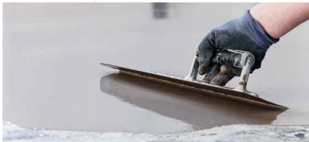
▲ APPLICATION À LA TALOCHE LISSEUSE EN POSITION ACCROUPEE.
